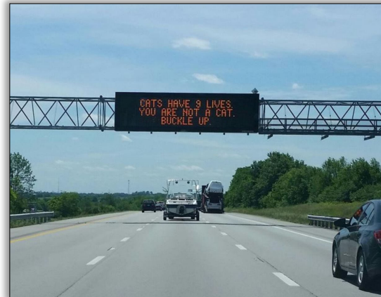
Variable Message Signage
