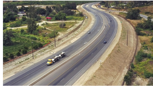
Shoulder Widening (Ampliación del Lado de la Carretera) Proyecto que amplía el pavimento por la orilla de una autopista por seguridad en caso de emergencias.
